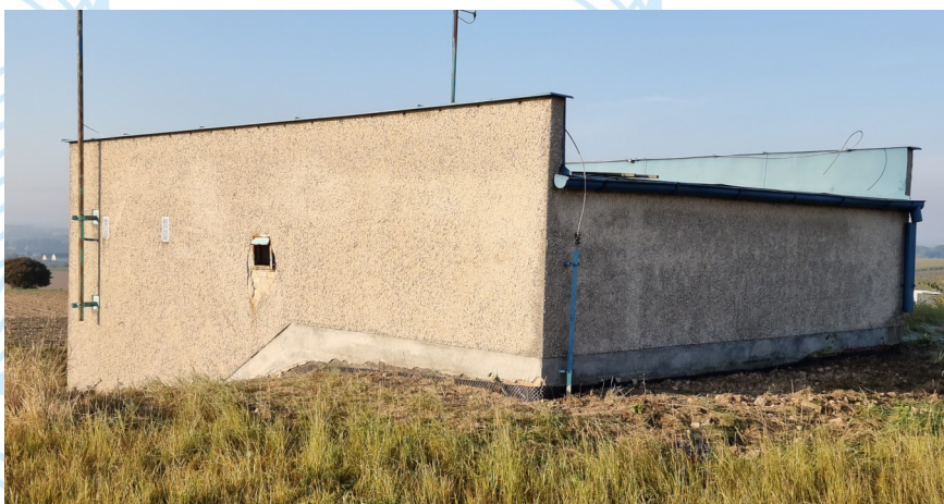
PŮVODNÍ STAV VODOJEMU PŘED REKONSTRUKCÍ V LETECH 2021-2023
